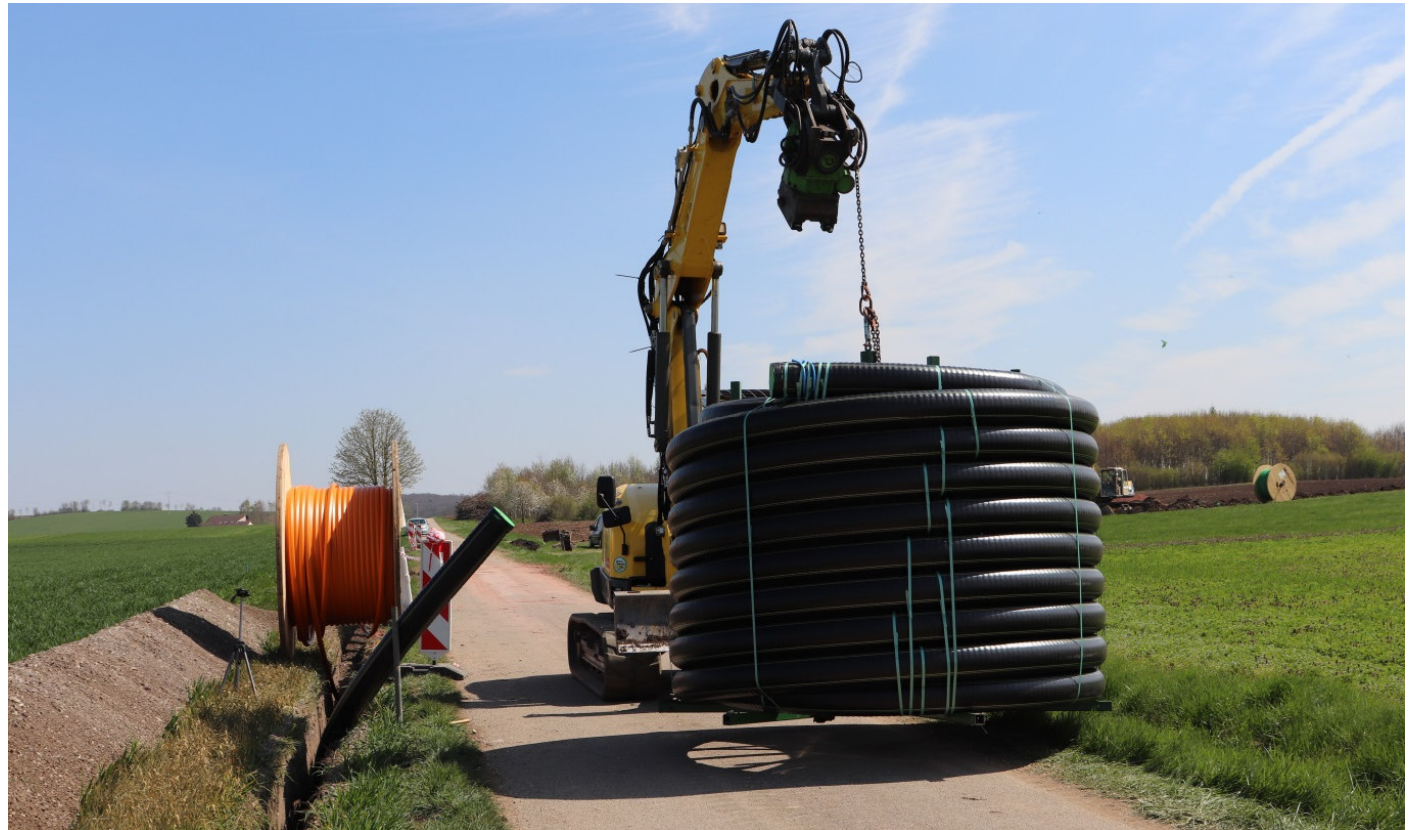
Grabenfräse + Verlegung der Wärmerohre
