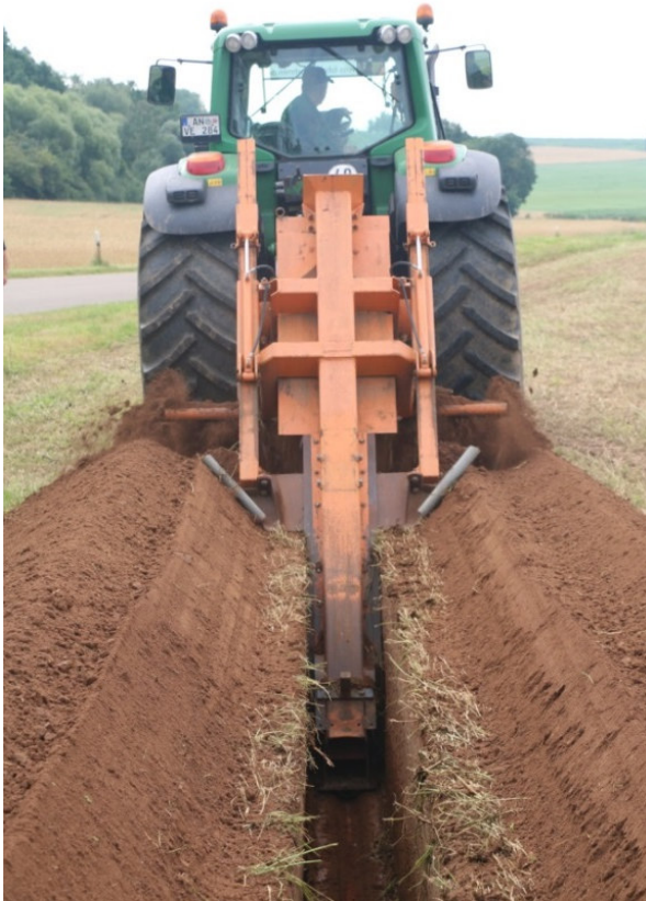
Grabenfräse + Verlegung der Wärmerohre
